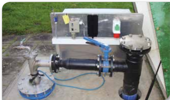
Renser og desinficere boringer i samme arbejdsgang.
