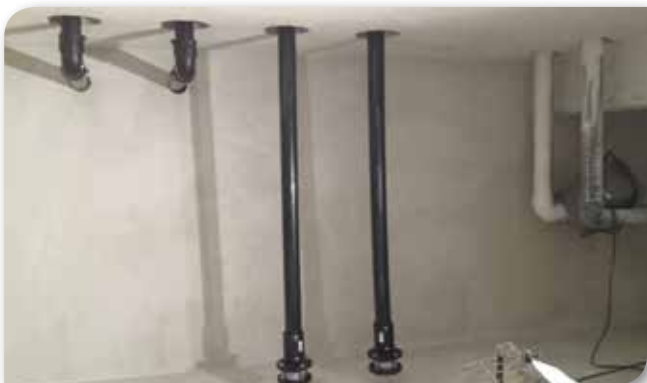
Rentvandsbeholder efter renovering og coating
