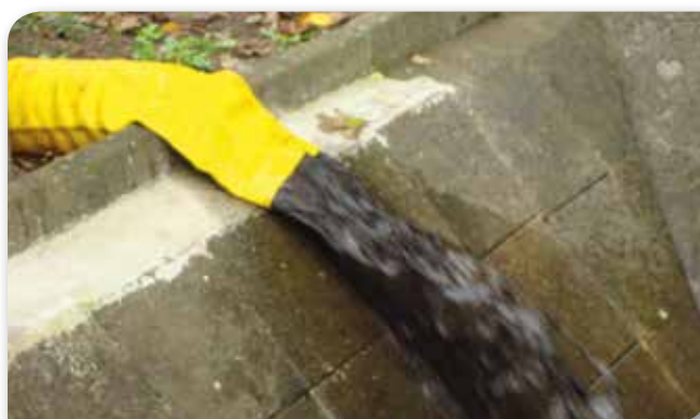
Rens af råvandsledning
